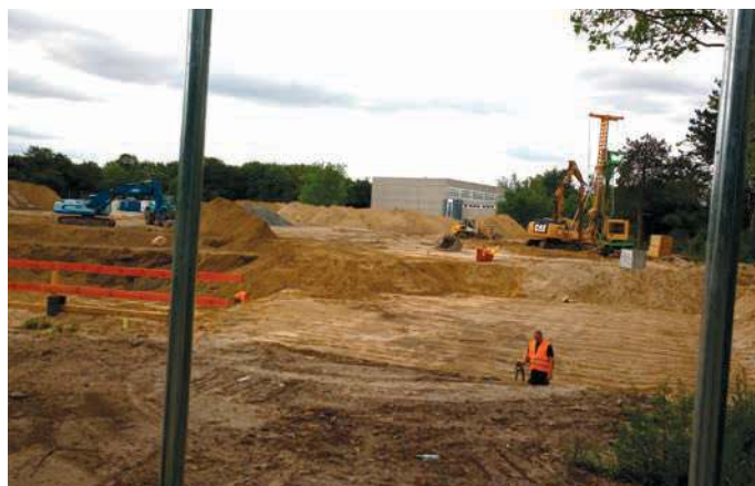
Die ersten Bagger rollen (Bild vom 01.07.2020)
