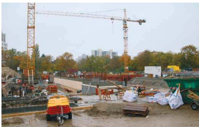
Der Schulneubau am Tag der Grundsteinlegung
